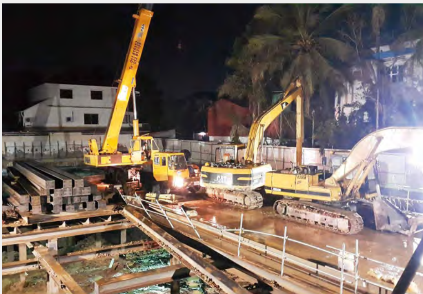
▲柬埔寨辦公大樓夜間地下室開挖及擋土設施工程。
